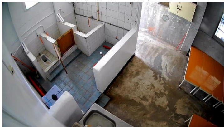
盥洗區施工完成
