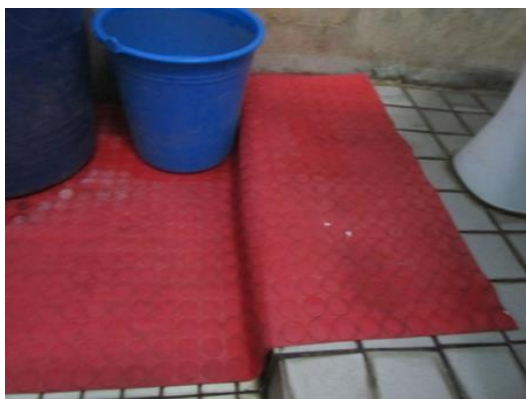
圖 24 舍房廁所地板鋪設防滑墊
