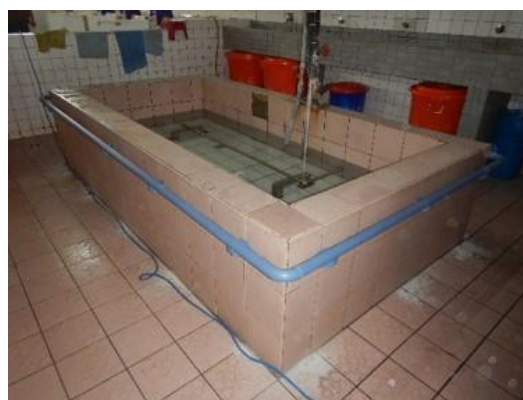
圖 23 浴室安裝扶手
