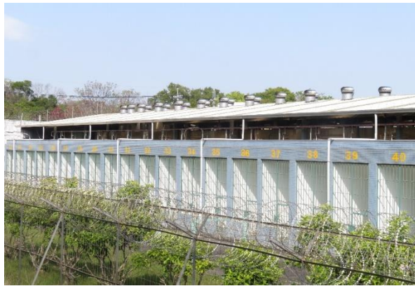
圖 17 屋頂裝設渦輪式通風設備
