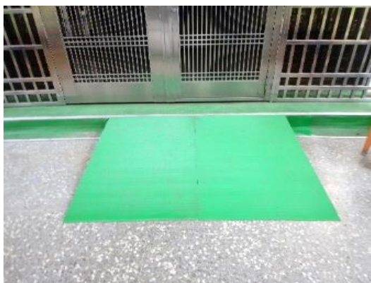
圖 20 行政大樓無障礙坡道
