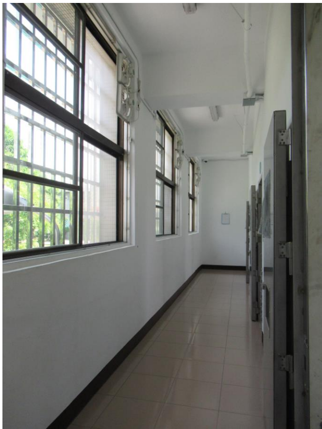
第三生活區-1、2、3 寢室走廊-排風扇
