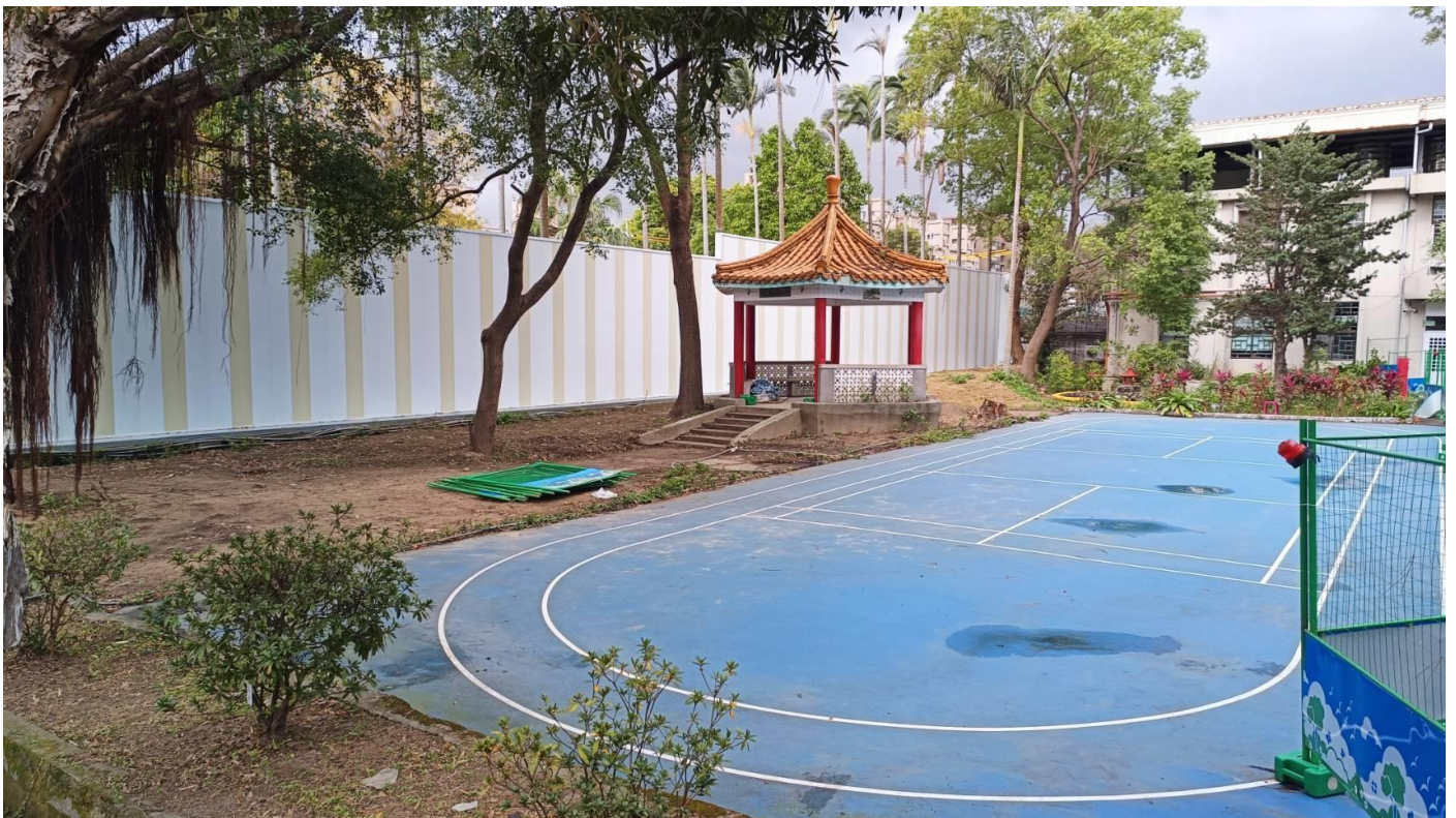
廣場施工中(運動場已完成)
