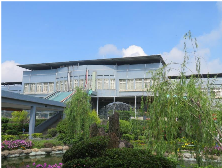
圖1-10屋頂架設太陽能板阻絕熱度
