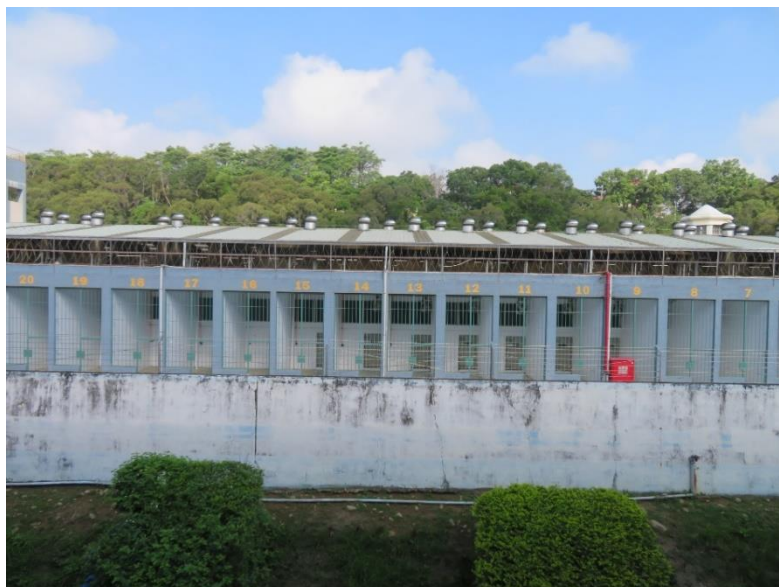
圖1-11屋頂裝設通風器強化室內通風效果
