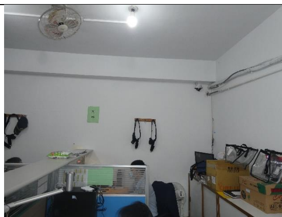
以錄影方式記錄留存開拆過程
