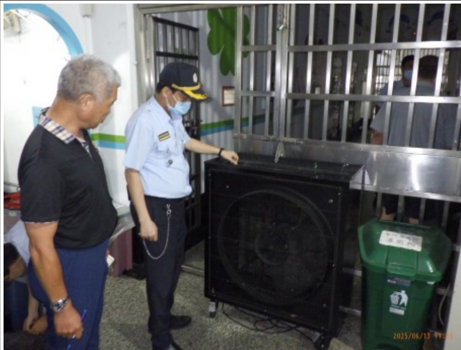
走廊設置大風量靜音風扇通風
