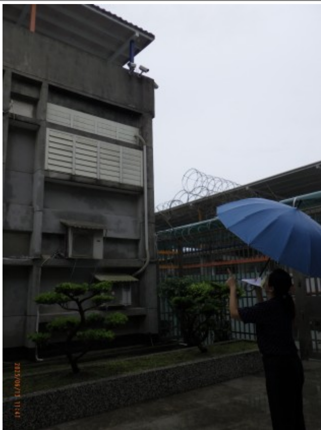
屋頂鐵皮隔熱設施
