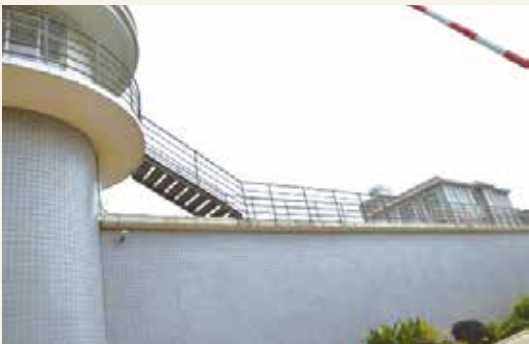
雲南安寧監獄圍牆巡邏道
