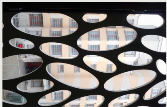
圖 23：泰格爾監獄預防處遇大樓鐵窗設計，相較於一般舍房大樓直條柱狀鐵窗
