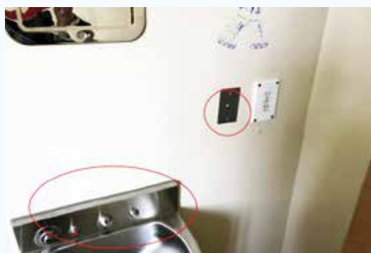
圖 88：Millheaven 監獄洗手台按鈕特殊設計及舍房報告燈按鈕
