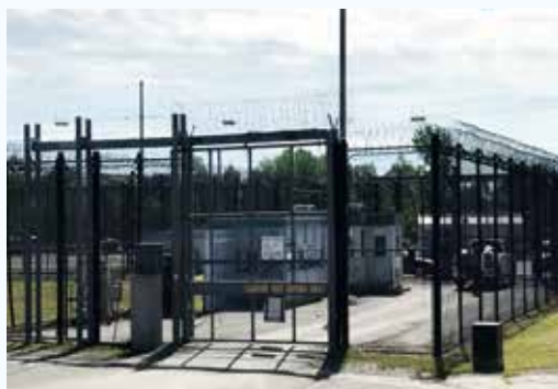
圖 28：Millhaven 監獄車檢站
