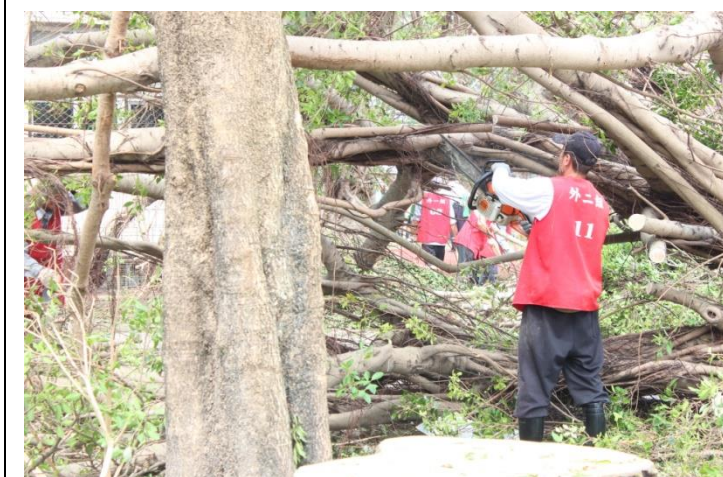
新生國中教學大樓前倒塌樹木清運
