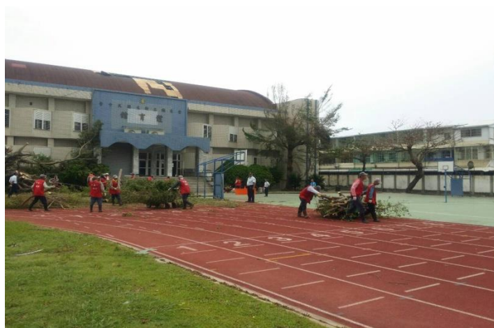
新生國中操場倒塌樹木清運
