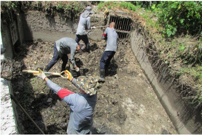
臺東縣鹿野鄉水利會鹿寮圳-阻塞水道淤泥清除
