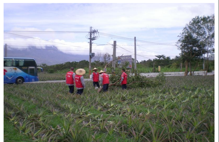
臺東縣東 33 線受損鳳梨園-樹木清運
