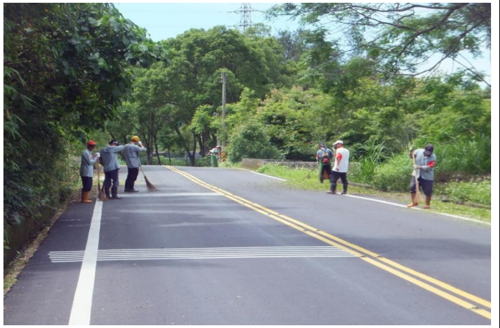
臺東縣東 33 線綠色隧道-道路清掃
